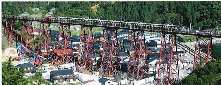
架け替え前の余部鉄橋
