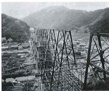
橋脚が並んだ建設工事現場（明治44年8月）
